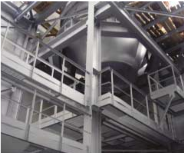
Рис. 2. Нижнесергинский метизно-металлургический завод г. Ревда, помещение грануляции ЭСПЦ-1
